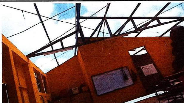
Foto 6: Pintura de costanera
