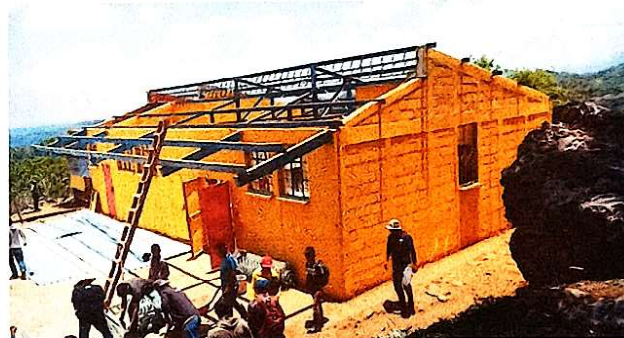
Foto 4: colocacion de costenas
