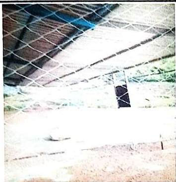
Foto 1: Instalacion de la Maya
