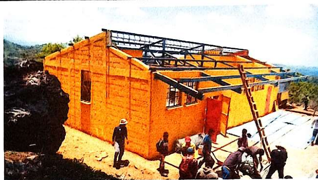
Foto 2: Cambio de Techos y la estructura
